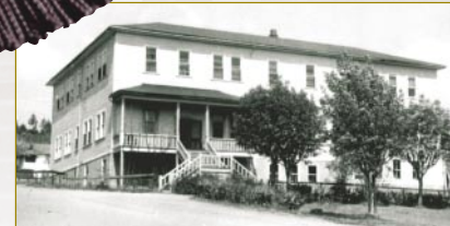
Couvent/école à l'angle nord-ouest du Carré Laval après les rénovations de 1937. Convent/School on northwest corner of Laval Square after 1937 renovations.
